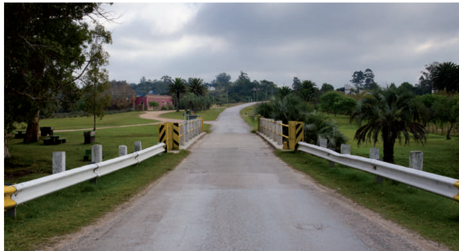
Puente sobre el arroyo El Pintado.
