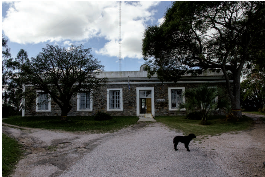
Local Policial refaccionado.
