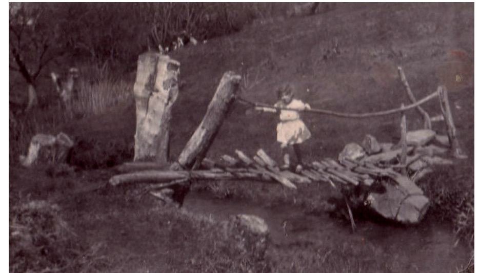
Antiguo puente de madera sobre el arroyo El Pintado.
