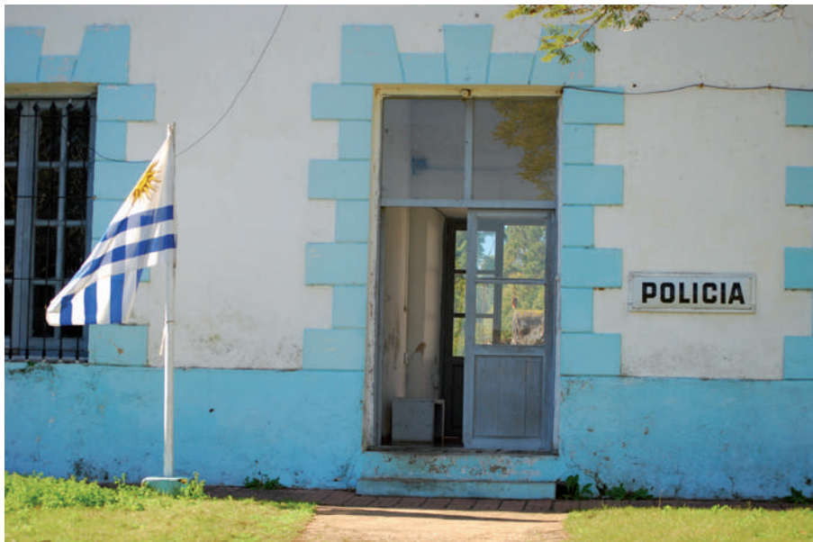
Comisaría previo a la refacción.
